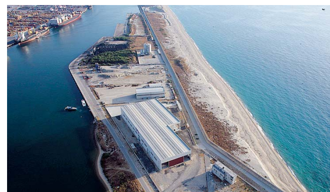
Panoramica del cantiere "Zen Yacht" a Gioia Tauro
